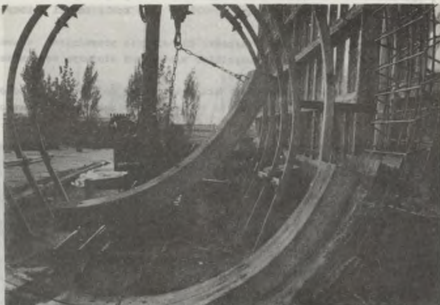
Rys. 5. Układanie segmentów spagowych w stoisku technologicznym
