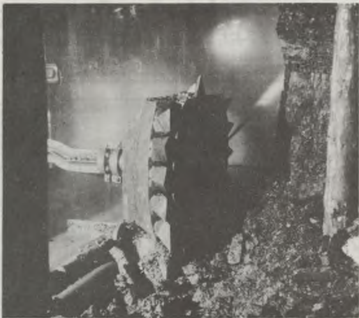
Rys. 5. Hydrostrug z dwiema dyszami rozbieżnymi przed rozpoczęciem urabiania nowego sabioru
