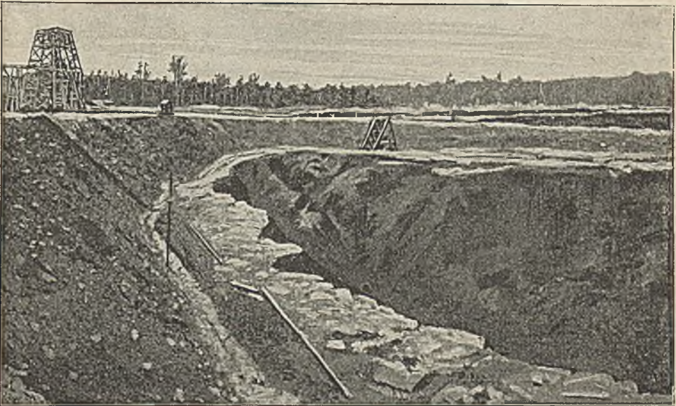
412. Добыча руды колодцами на рудникѣ Куборнъ (Миннесота).
