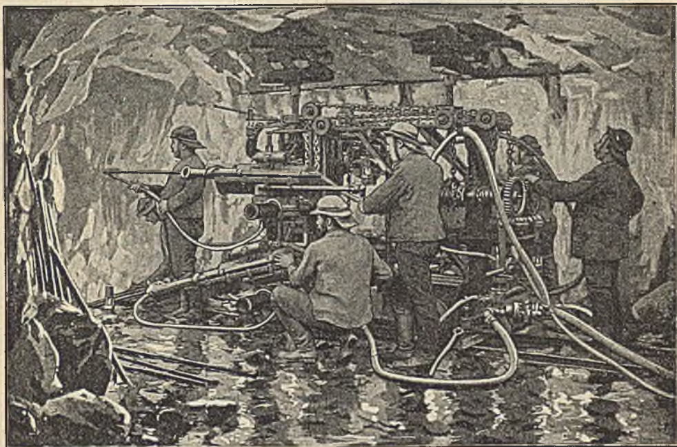
129. Подвижная рама для перфораторовъ Мейера.
