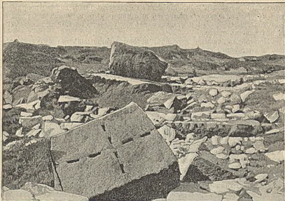
10. Обработка гранита у древних египтянь. Гранитная глыба съ углублениями отъ клиньевъ съ каменоломни близъ Ассуана.
