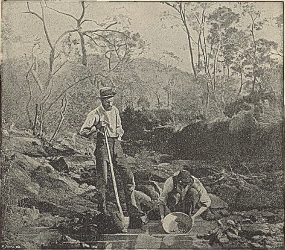
183. Проба на содержаніе золота промывкою песка въ лоткѣ.
