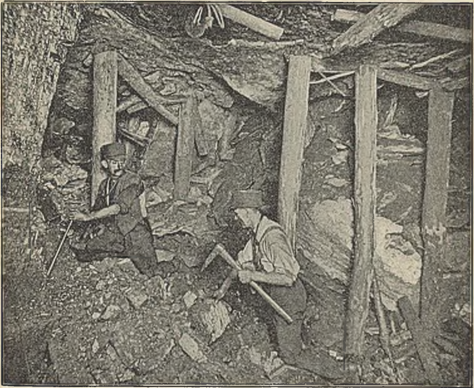
268. Работы у обрушенія.
