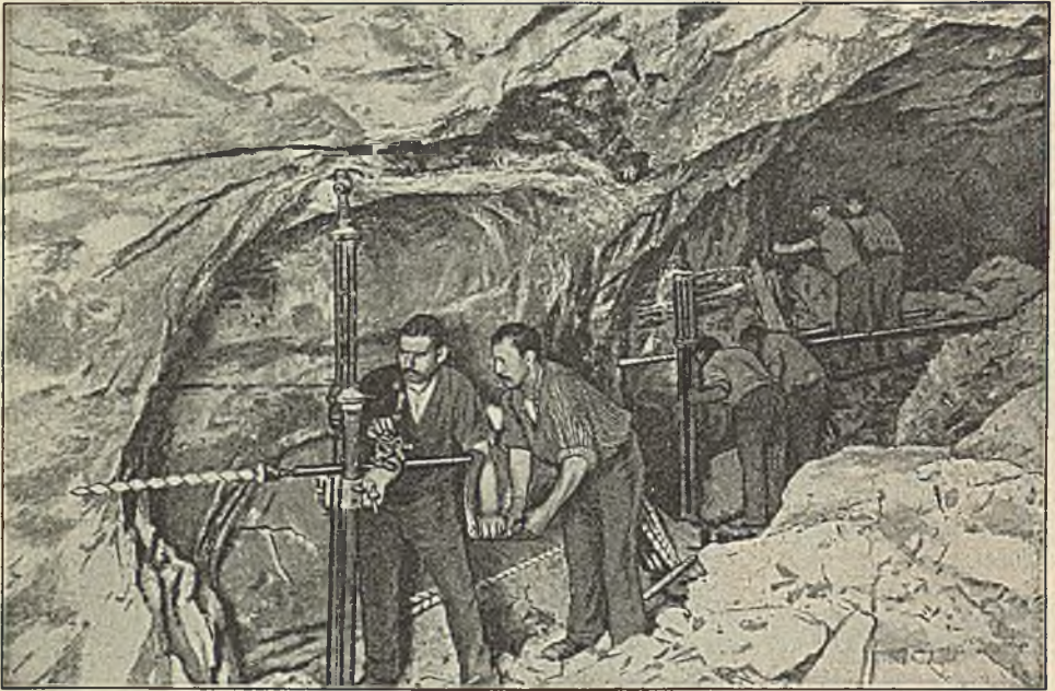
124. Буреніе шпуровъ первораторомъ Лисбе въ каменносоляномъ рудникѣ Леопольдсгалле. Съ фотографіи Бернера.
