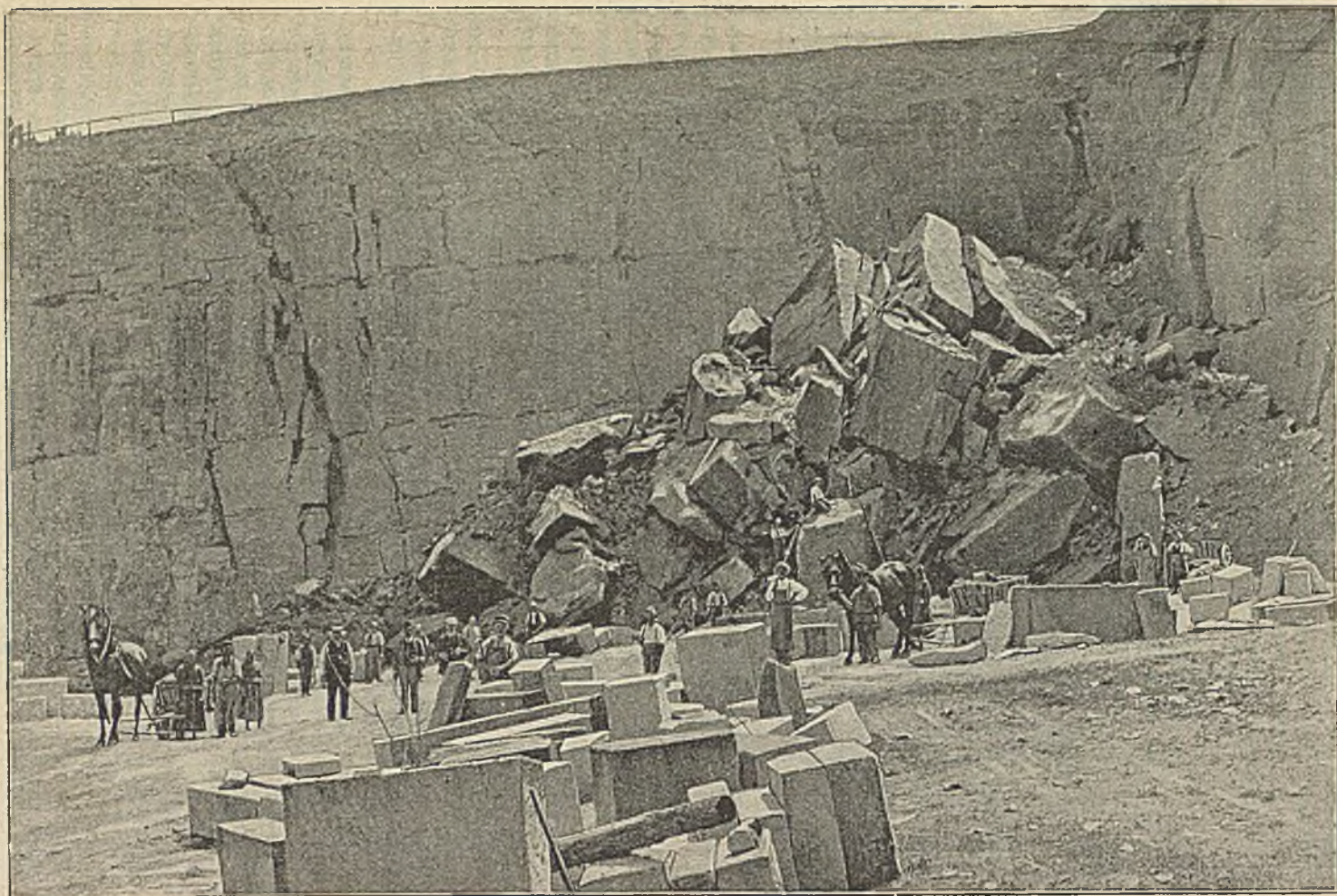
322. Добыча песчаника на ломкахъ г. Лотце въ Пирнѣ. Видъ ломокъ послѣ обрушенія уступа.
