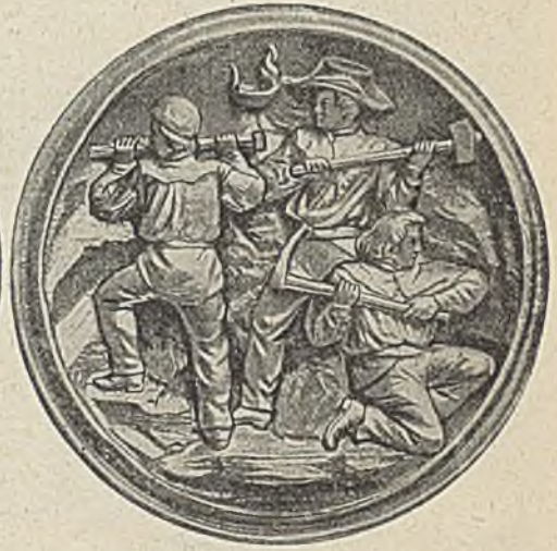
127. Двуручное буреніе. Съ рельефа проф. Хейхлера.
