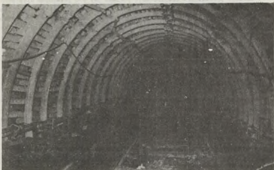
Zdjęcie 1. Zabezpieczenie przekopu przed eksploatacją za pomocą trzech ciągów szyn przymocowanych zamkami do łuków obudowy. Zdjęcie wykonane od strony południowej
