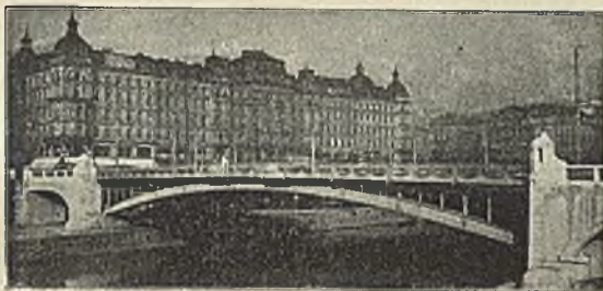
Abb. 219. Josef Hackhofer Marienbrücke über den Donaukanal in Wien
