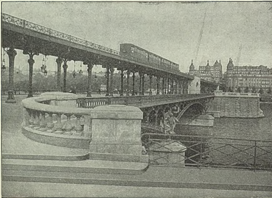
Abb. 208. Paris: Hochbahn auf der Passybrücke, Linie 5
