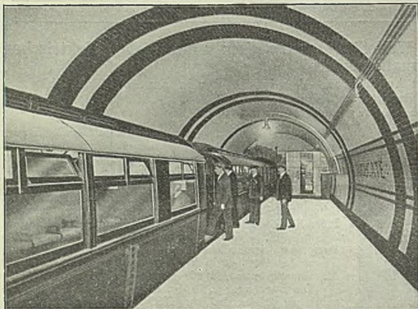
Abb. 203. London: Untergrundbahnhof der Hampsteadbahn zu Highgate
