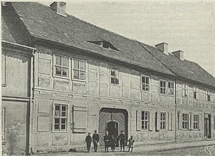
Abb. 253. Fachwerkhäuser in Luckenwalde
