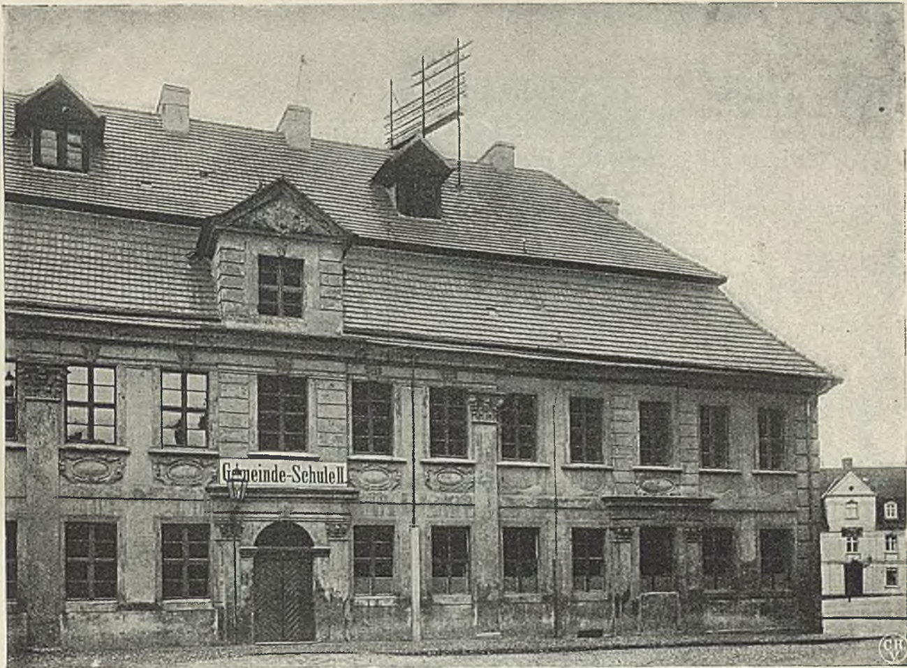
Abb. 272. Ehemaliges Gymnasium in Cottbus (vgl. Abb. 270 und 274)
