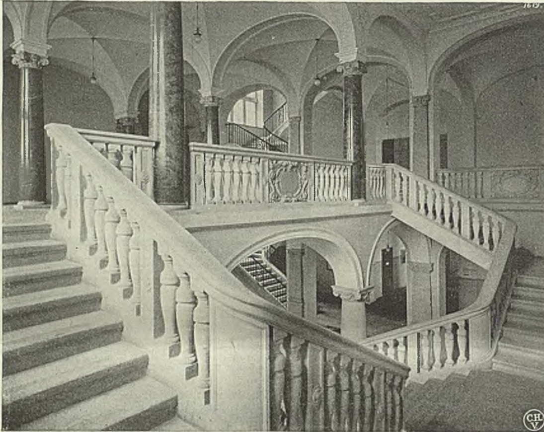
Abb. 320. Haupttreppenhaus der Königlichen Akademie in Posen Die unteren Säulen und Pilaster sowie das Brüstungsgeländer in Sandsteinnachmung, Stufen und Platten in Marmornachmung
