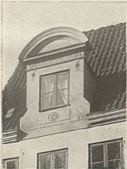
Dacherker Königstraße Nr. 94
