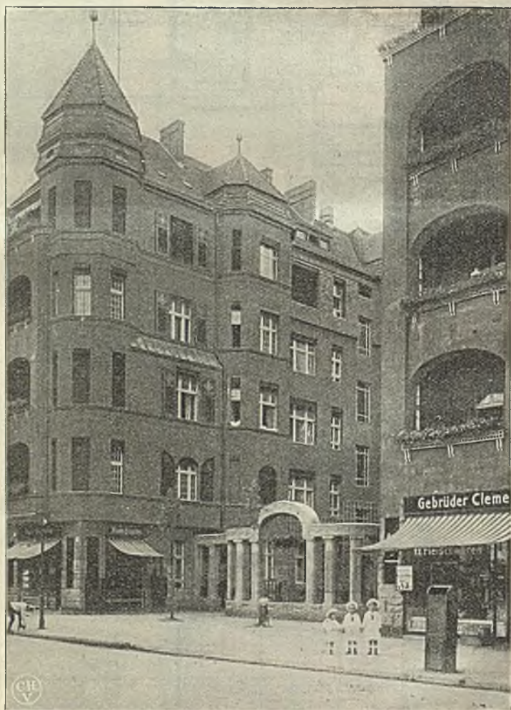
Abb. 6. Genossenschaftshaus in Charlottenburg Architekt: Feldhuber in Berlin
