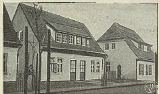
Abb. 33. Zweifamilienhaus zu Einswarden bei Bremen. Arch. H. Wagner, Bremen
