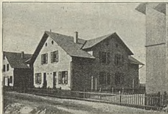
Abb. 26. Arbeiterhaus der badischen Anilin- und Sodafabriken Hemshof bei Ludwigshafen
