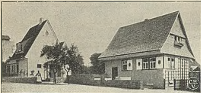
Abb. 117. Einfamilienhaus Cloos auf der Landesausstellung in Darmstadt 1909. Architekt Walbe. 70 qm Nutzfläche, 4194,43 M. Baukosten
