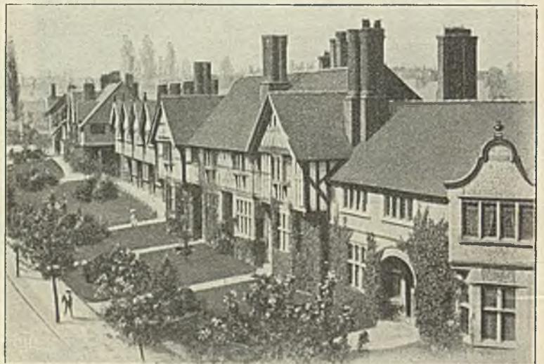
Abb. 102. Reihenhäuser in Port Sunlight. Architekt W. Owen u. a.
