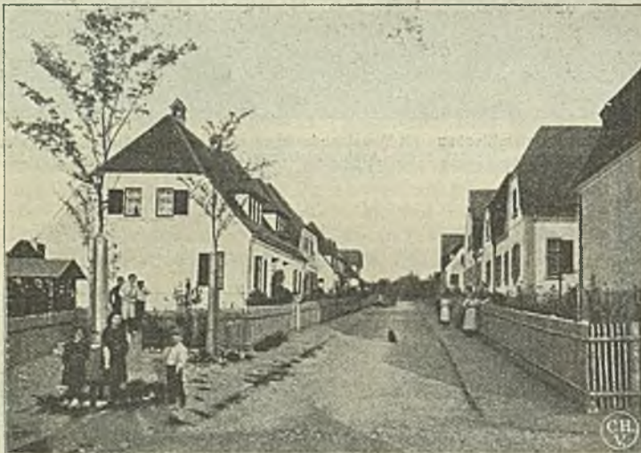
Abb. 124. Siedlung Römerweg, Starengasse, neuere Anlagen mit demselben Grundriß. Architekt Stadtbaurat Holch
