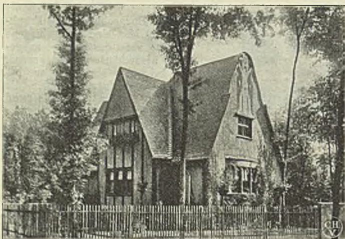
Abb. 165. Landhaus Belthan in Buchschlag 149,90 qm bebaute Fläche. Baukosten 19 000 M. Architekt Leonhardt, Frankfurt a. M.
