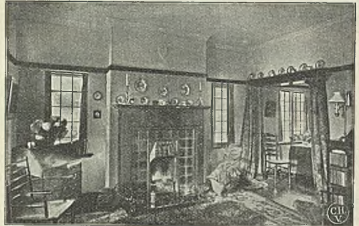
Abb. 177. Wohnraum in einem Beamtenwohnhaus in Bournville
