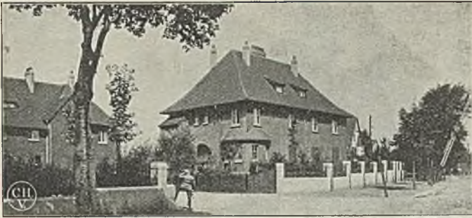
Abb. 167. Beamtenhaus der Zeche Hannibal I Architekt Baurat Schmolh
