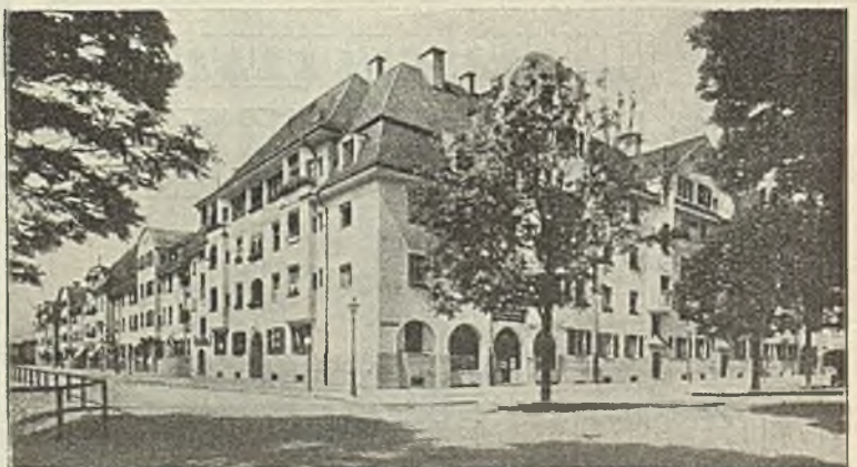
Abb. 463. München, Dachauer und Karl-Singer-Straße. Architekt J. Mund
