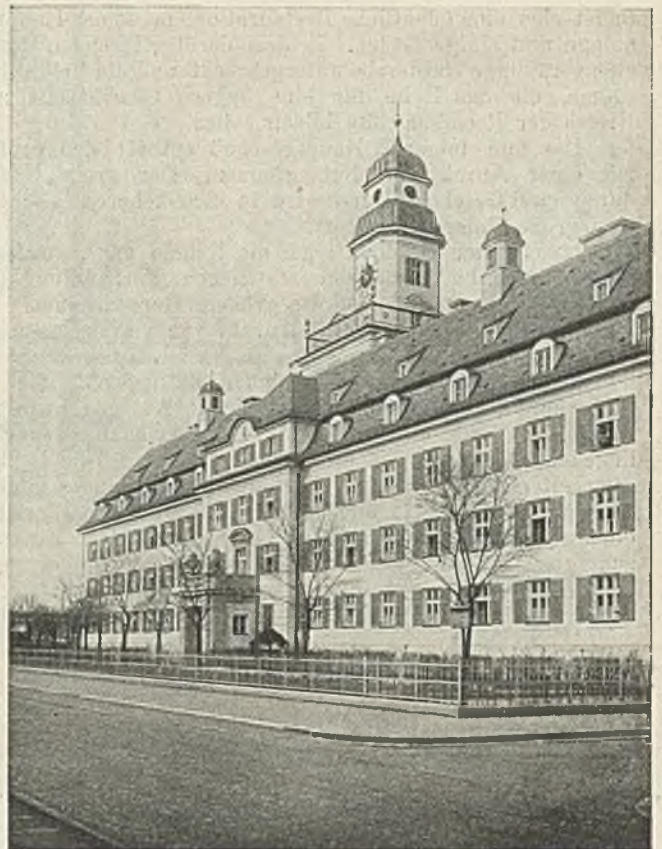
Abb. 498. Bürgerheim, Dall' Armi Straße 1. Architekt Baurat Dr.-Ing. E. h. Hans Grüssel
