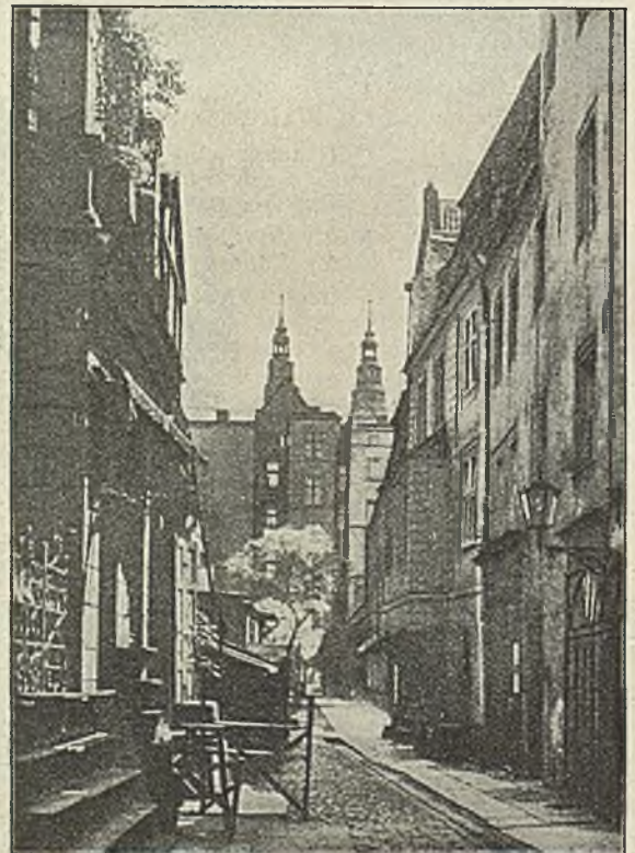
Abb. 58. Topfkran zu Breslau
