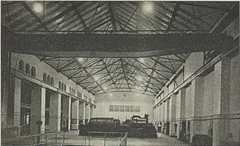
Abb. 250. Blick auf die Warte aus dem Maschinensaal des Großkraftwerk Erfurt A. G.
