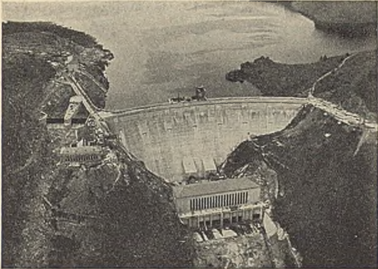
Abb. 379. Saaletalsperre am Bleiloch, Sperrmauer mit Kraftwerk und Umspannwerk.
