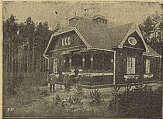
Zerlegbares, transportables doppelwandiges Holzhaus
