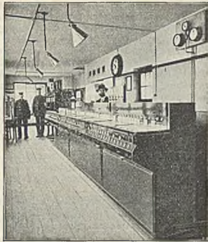
Abb. 388. Schalter für ein einflügeliges Signal. C. Stahmer
