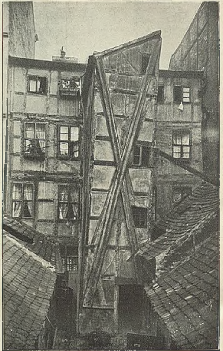
Abb. 412. Hofansicht des Hauses Fischerbrücke 2 Nach einer Photographie von F. Albert Schwartz, Berlin NW 87
