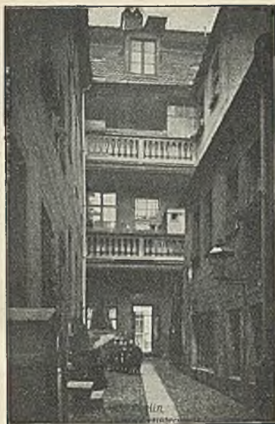
Abb. 413. Hofansicht des Hauses Fischerstr. 29 Nach einer Photographie von Arpád Johann Schuh, Berlin C 2
