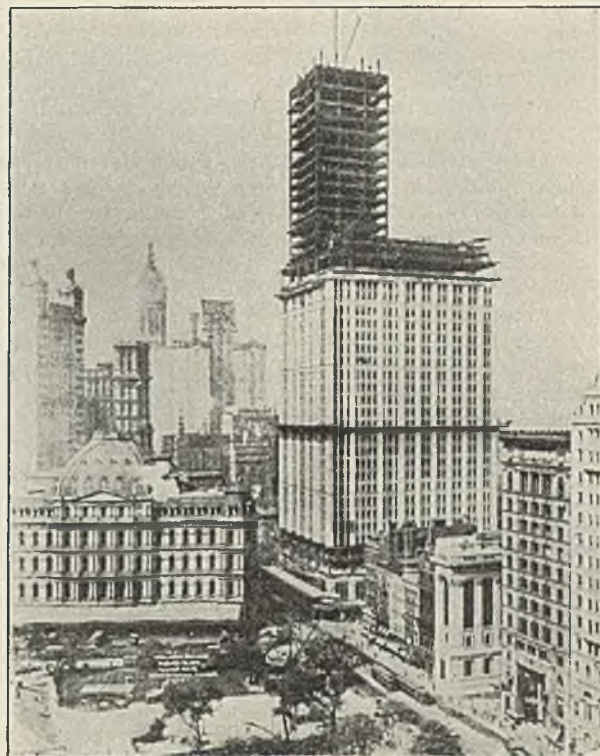
Abb. 491. New York, Montage des „Woolworth Building“
