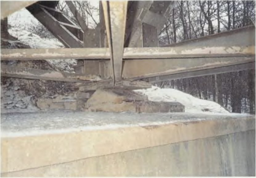
Fot.1.5. Przesunięte łożysko stałe na zewnątrz kratowego przęsła wspornikowego oraz doraźne jego podparcie Photo.1.5. Shifted permanent bearing outside of a braced grid span and its emergency support
