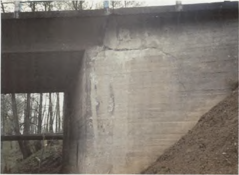
Fot.1.11. Ścięcie skrzydeł przyczółka na poziomie niszy podłożyskowej Photo.1.11. Shearing of abutment wings at the level of subbearing niche
