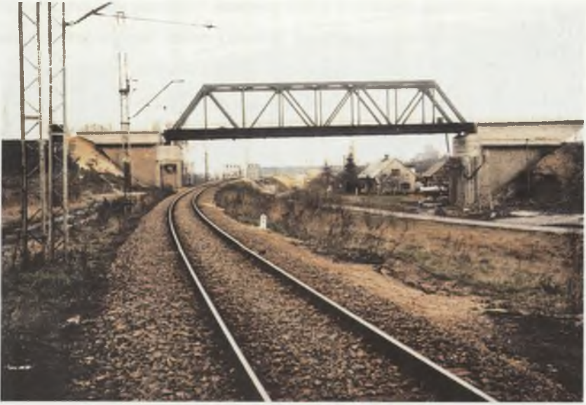
Fot.1.19. Rektyfikacja niwelety mostu kolejowego (nadbudowa przyczółków) Photo.1.19. Rectification of formation line of a railway bridge (superstructure of abutment)
