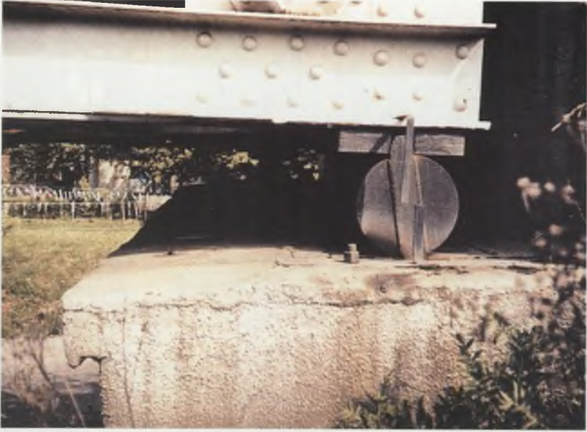
Fot.1.3. Graniczne położenie wałka, wielkość przesunięcia widoczna na wskaźniku pomiarowym Photo.1.3. Limiting position of roller, magnitude of shifting visible on measuring index
