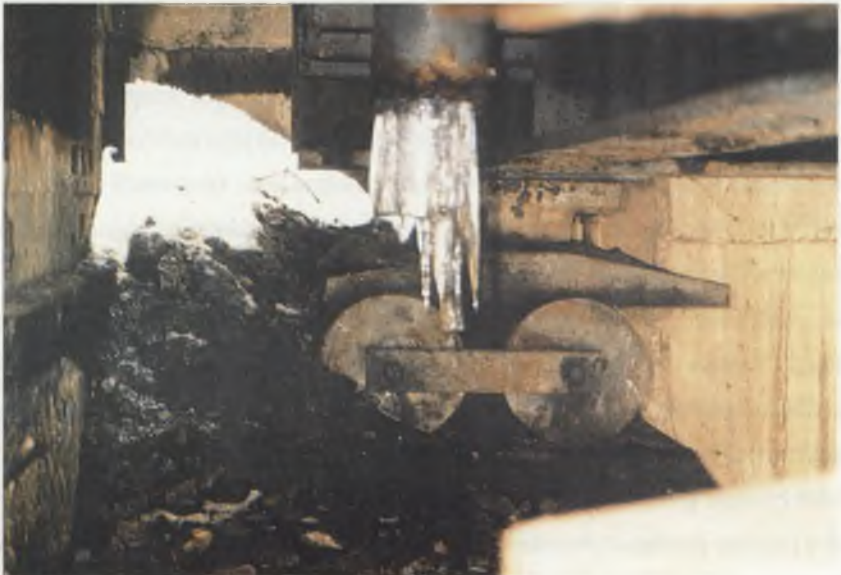
Fot.1.2. Graniczne przesunięcie przęsła na łożysku ruchomym Photo.1.2. Limiting shifting of span on expansion bearing
