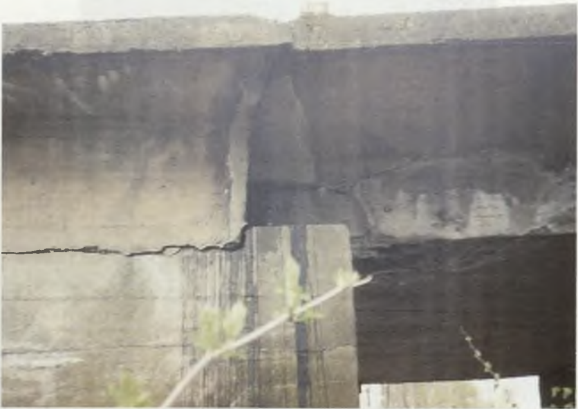
Fot.1.12. Ścięcie skrzydeł przyczółka na poziomie niszy podłożyskowej Photo.1.12. Shearing of abutment wings at the level of subbearing niche
