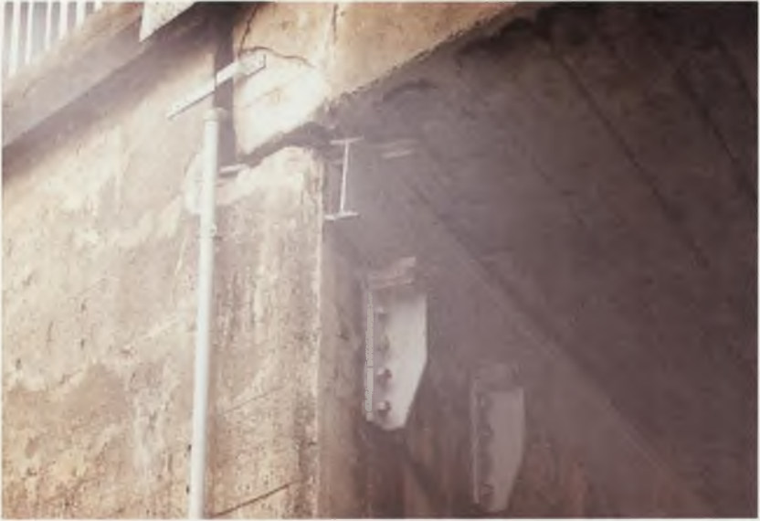
Fot.1.17. Przystosowanie doraźne niszy podłożyskowej do przejścia wpływów projektowanej eksploatacji górniczej
