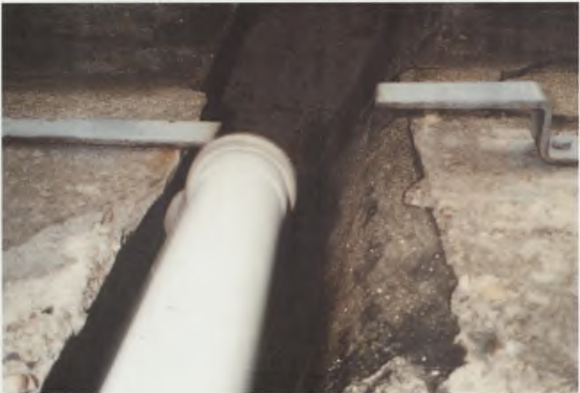
Fot.1.18. Podłużne i poprzeczne przesunięcie przęsła
