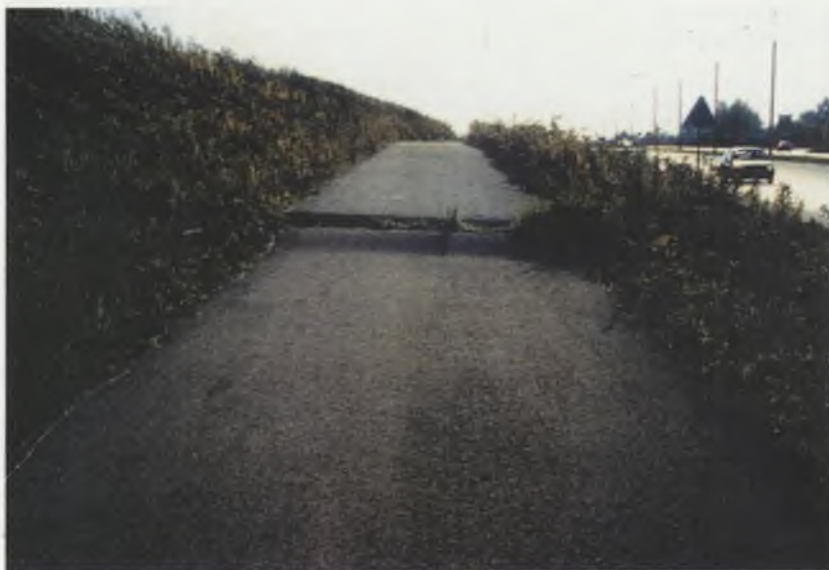
Fot. 1.14. Deformacja terenu spowodowana eksploatacją górniczą Photo.1.14. Land deformation caused by mining
