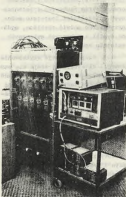
Kys. 6. Pośredni prądowy przemiennik częstotliwości PDC-50 kVA do zasilania silników synchronicznych
