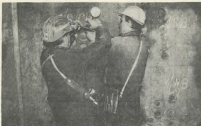
Rys. 9. Widok fragmentu czynności związanych z pomiarem przyczepności na stanowisku nr I
