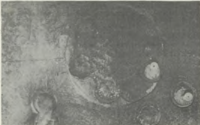
Rys. 8. Widok zbliżenia stanowiska badawczego nr I po przewierceniu warstwy betonowej
