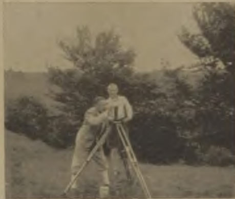
Bei der Arbeit mit dem Phototheodolit.
