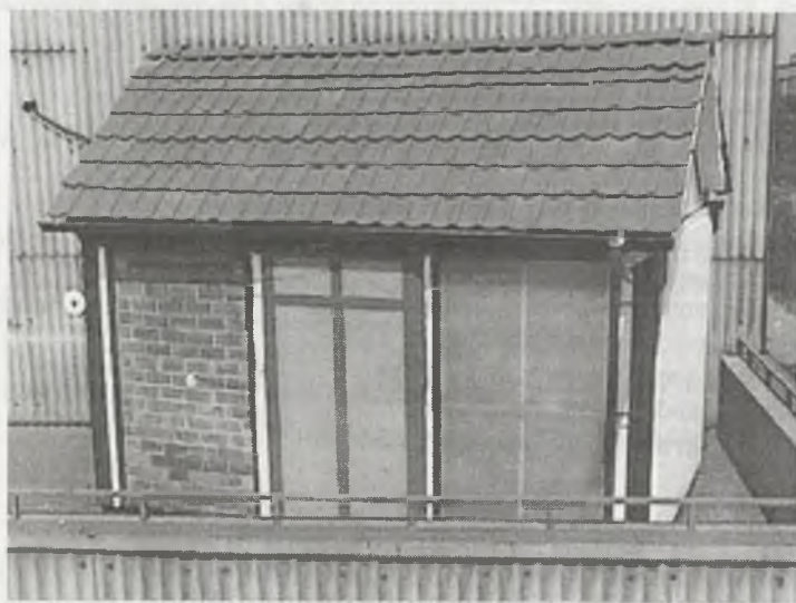
Fot. 1 Widok komory od strony badanych elementów
