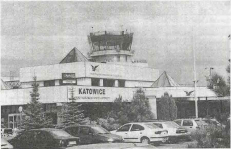
Rys.4. Nowy dworzec portu lotniczego Fig.4. New air terminal
