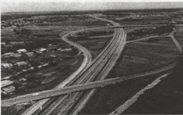
Fot.1. Przykład układu komunikacyjnego : trasa ekspresowa i towarzysząca infrastruktura drogową Fot.1. The sample of the communication topology : the express road and the associated road's infrastructure
