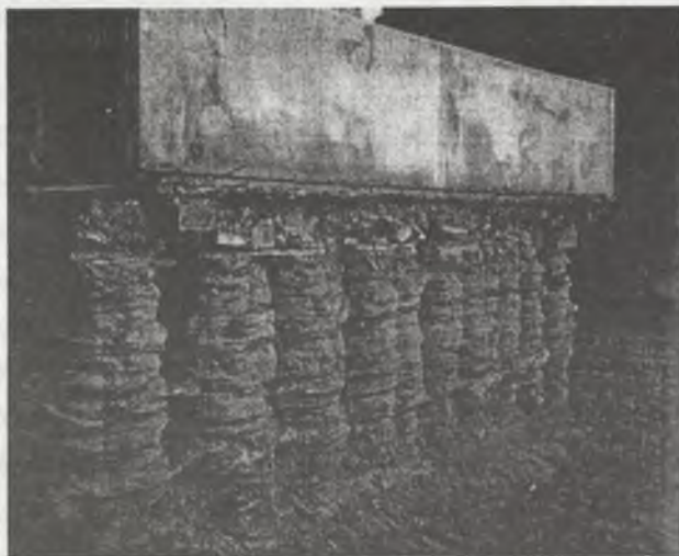
Fot. 2. Mikropale pod podporą mostu Photo 2. Micro piles under bridge support
