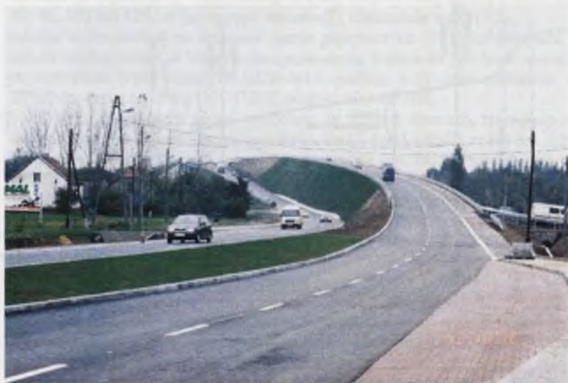
Fot.6. Widok wykonanego nasypu od strony miasta Jastrzębie Zdrój w dniu oddania obiektu do eksploatacji
