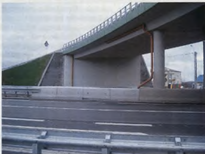
Fot.4. Skrzydła przyczółków mostowych z pionowo ułożonych, prefabrykowanych bloczków betonowych systemu LEROMUR ® kotwionych geosiatką FORNIT ®
