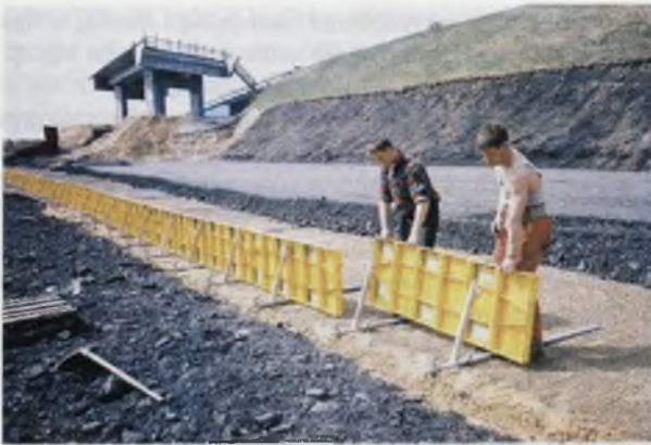
Fot. 5. Wykonywanie kolejnej warstwy zbrojenia z zastosowaniem szalunków przestawnych z Przedsiębiorstwa Realizacyjnego INORA®
