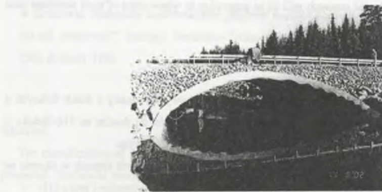
Rys. 1. Widok z boku na most bezpośrednio przed badaniami dynamicznymi Fig. 1. Side view on the bridge immediately before dynamic measurements
