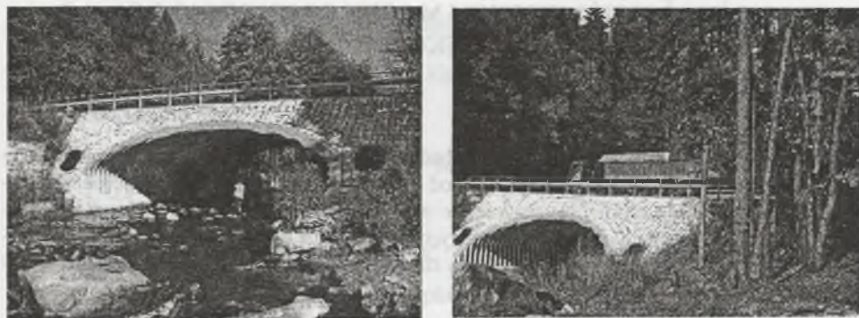
Rys. 1. Widok mostu gruntowo-powłokowego podczas badań Fig.1. View of the soil-steel bridge during in situ tests
