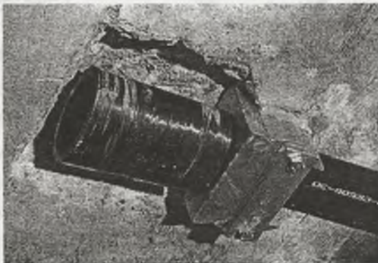
Rys. 3. Głowica wraz z blokiem kotwiącym systemu zakotwień StressHead (SH) Fig. 3. The head and the anchor of StressHead system
