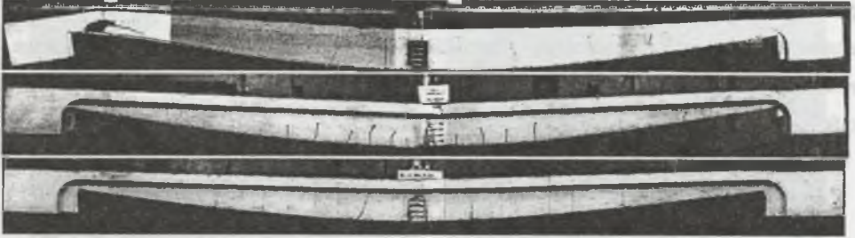
Rys. 5. Stan zarysowania w modelach rzeczywistych Fig. 5. Crack state in real models of girders
