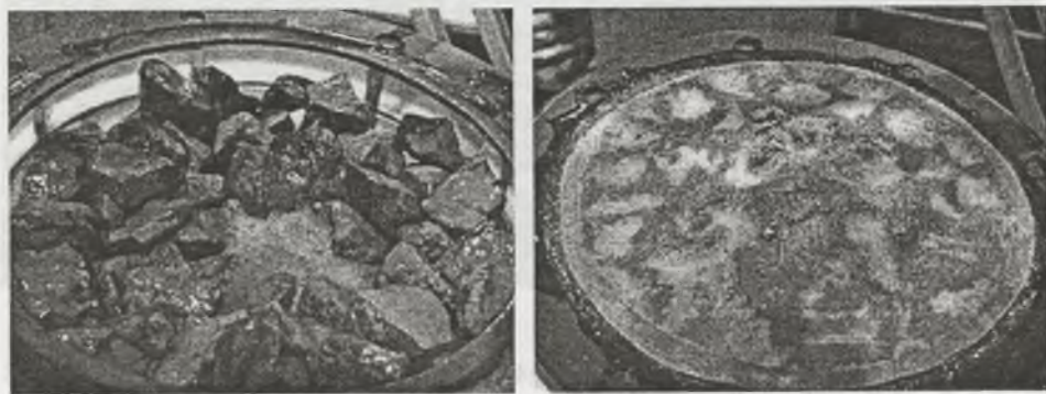
Rys. 4. Efekt zjawisk sufozyjnych – wypłukany grunt spod geowłókniny
