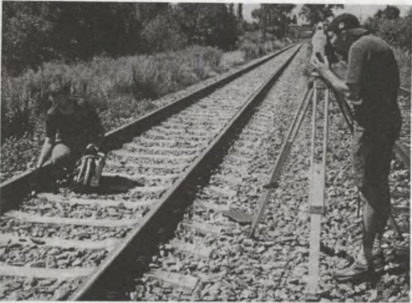
Rys.7. Zasadniczy pomiar inwentaryzacyjny osi toru
