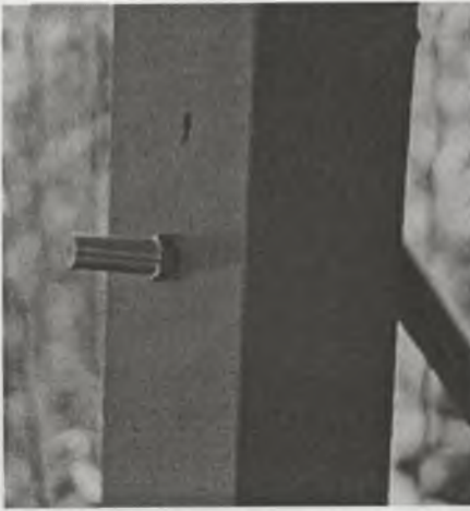
Rys.4. Bolec jako znak regulacji osi toru Fig.4. Pin – a railway track axis regulation mark
