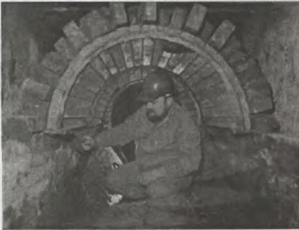
Rys.13. Murowanie zbiorczego kolektora sanitarnego w Zabrze pod ul. Piłsudskiego. Kanał murowany posiadał przekrój owalny o wymiarach w świetle h_0 = 1200 mm, b_0 = 1000 mm. Budowa w 1998 r.
