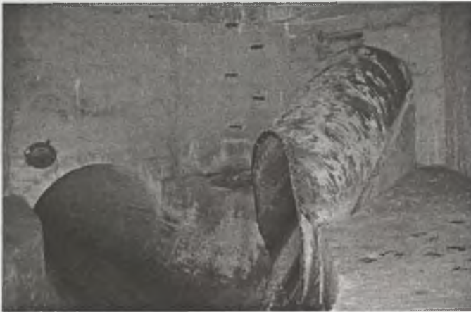
Rys.11. Widok komory rewizyjnej na wyżej pokazanym kolektorze deszczowym po stronie dopływu. Z prawej widoczny dopływ z dzielnicy Orłowice rurą PEHD \varnothing 800 mm, w głębi na lewo murowany kolektor \varnothing 1400 mm, prowadzący wody potoku Rydułtowskiego oraz wody opadowe z centrum miasta
