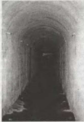
Rys.10. Widok przepustu w miejscowości Bronów pod 4-torową linią kolejową Zebrzydowice – Trzenin, który po awarii w XII/1997 r. został przebudowany i odremontowany w połowie 1998 r. Zdjęcie wykonane w październiku 2004 r.
