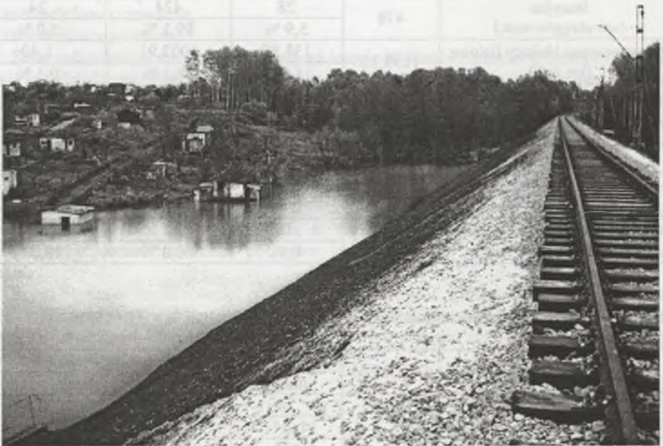
Rys.3. Podniesiony tor na czynnych szkodach górniczych (z lewej strony widoczne zalewisko) Fig.3. Elevated track on active mining damage areas (overflow land on the left)
