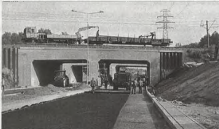
Fot. 3. Krótki tunel po zakończeniu prac budowlanych
