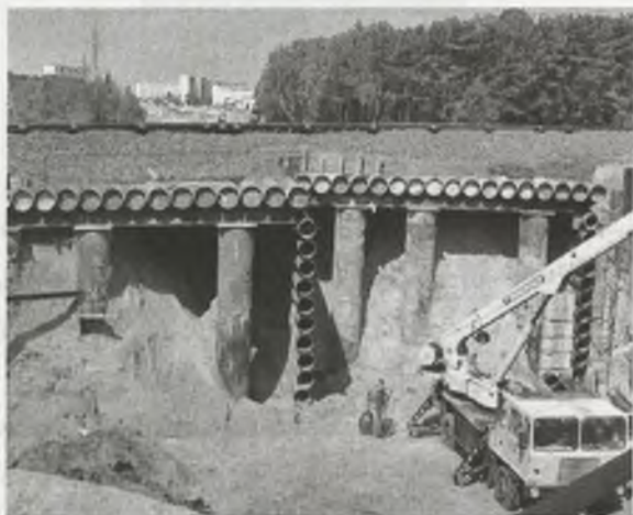
Fot. 2. Tunel w trakcie budowy. Etap rozpoczęcia wybierania gruntu z wnętrza obudowy Pic. 2. The underpass during construction
