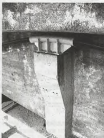
Fot. 4. Dewiator podporowy Pic. 4. The support deviator
