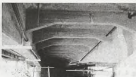
Fot. 2. Poprzecznice i kable sprężające Pic. 2. Cross beams and prestressing tendons
