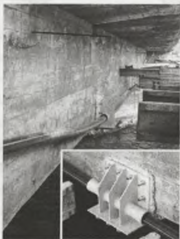
Fot. 3. Dewiator przesłowy Pic. 3. The midspan deviator
