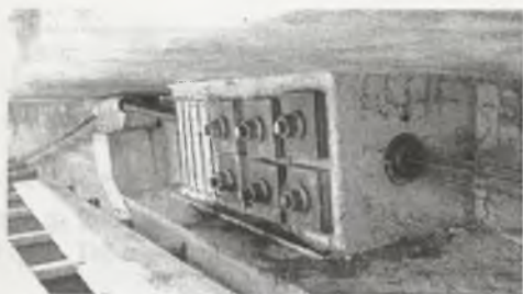
Fot. 1. Blok kotwiący i pręty sprężające Pic. 1. The anchorage block and prestressing bars
