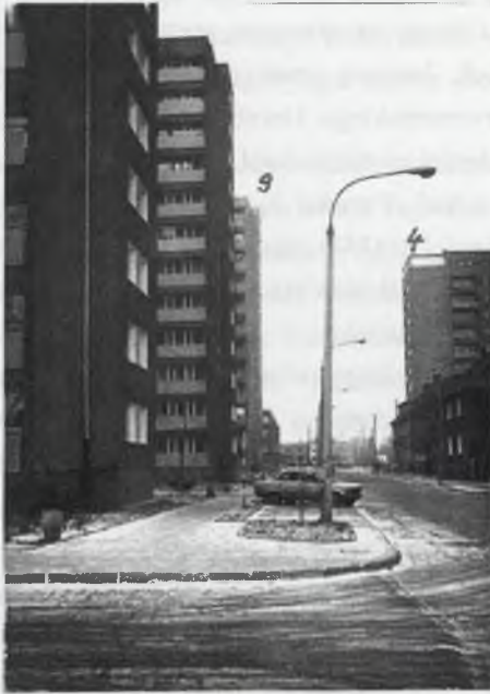
Fot. 1. Jedenastokondygnacyjny budynek w Raciborzu Fot.1. Eleventh floor building in Raciborz
