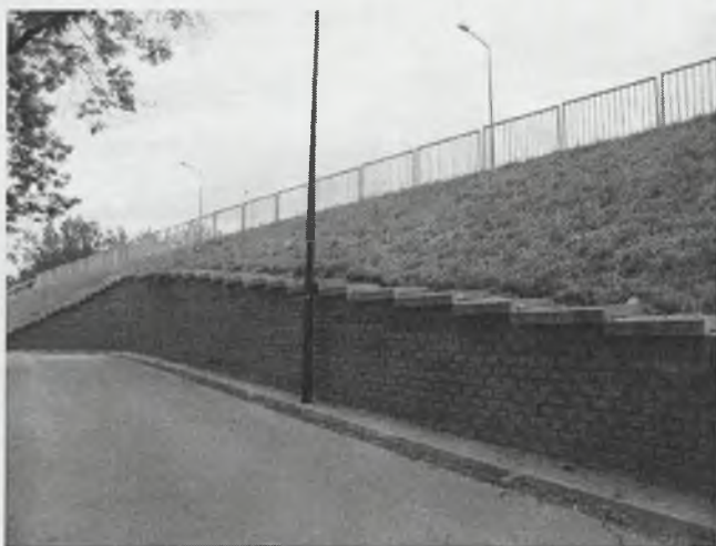
Fot. 5. Kompleksowe wzmocnienie podłoża nasypu drogowego Fot. 5. Complex strength of subsoil of road embankment
