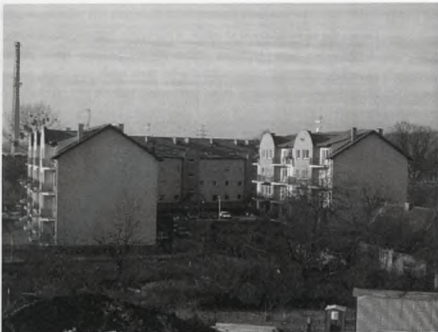
Fot. 3. Wzmocnienie podłoża budynków mieszkalnych kolumnami kamiennymi Fot. 3. Strength of subsoil of dwelling houses using stone columns
