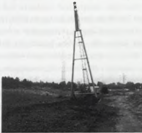
Fot. 2. Wzmocnienie podłoża w ciągu DTŚ metodą konsolidacji dynamicznej Fot. 2. Strengthening of subsoil during Road Diameter Route using dynamic consolidation
