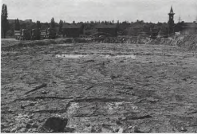
Rys. 2. Widok typowego układu ropy w dnie dużego wykopu budowlanego o skrajnie zróżnicowanych właściwościach, jednoczesne przesuszenie - bliższa strefa oraz nawodnienie - dalszy plan
