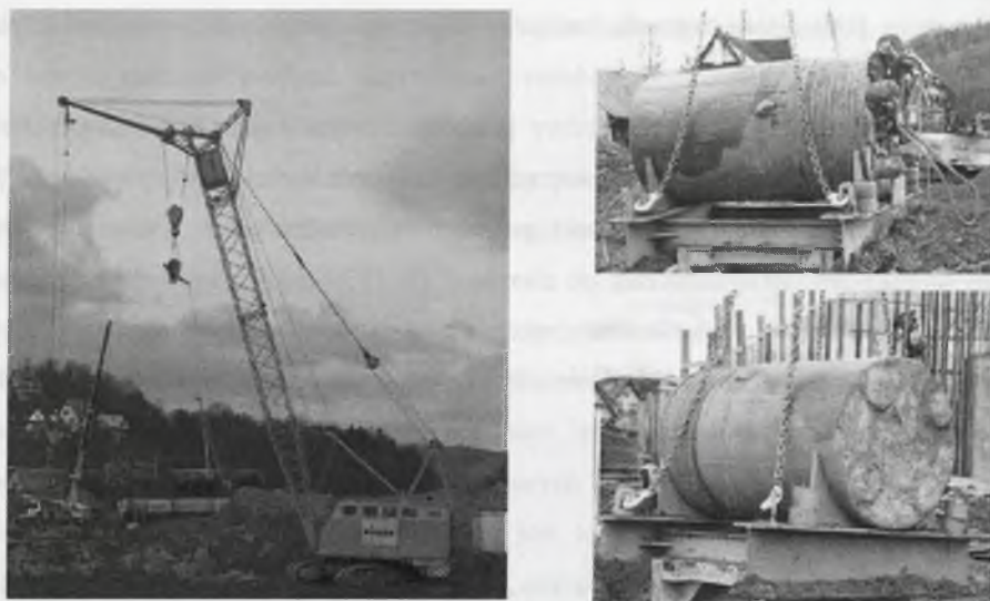
Rys. 2. Sprzęt do formowania kolumn metodą wymiany dynamicznej (Keller Polska) Fig. 2. Facility of dynamic replacement process (Keller Polska)
