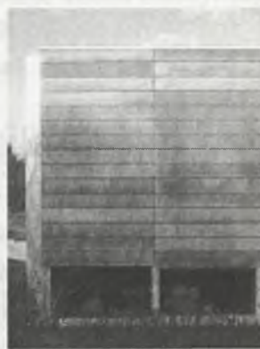
Fot. 13. Płyty elewacyjne z teksbetu [5] Pic. 13. Elevations plates made from TRC [5]
