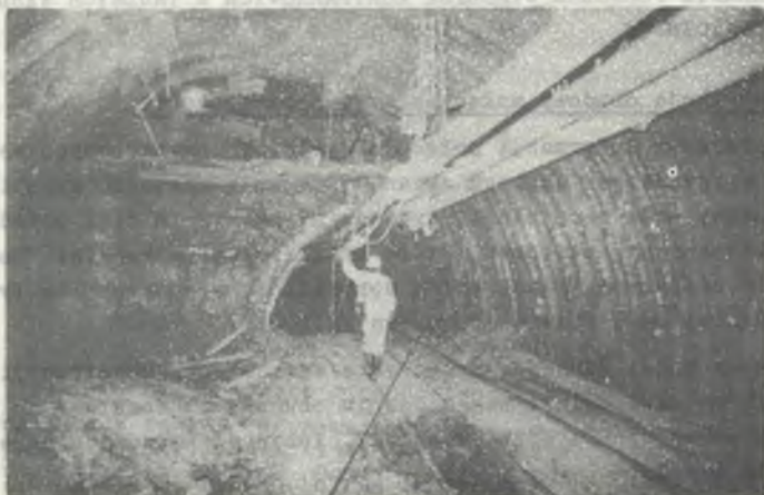
Rys. 17. Widok odgałęzienia R11 w fazie wykonywania wyrobiska głównego rozszerzającego się z widocznym ugięciem pokładu węgla nad chodnikiem głównym
