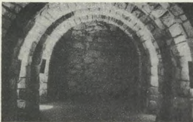
Fot. 6. Fragment trasy turystycznej z obudową z kamienia wzmocnioną łukami
