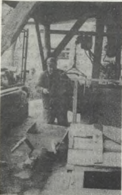
Fot. 3. Konstrukcja wiaty z widocznym żurawiem oraz z naczyniem wychylonym do transportu urobku Photo 3. Umbrella roof structure with visible crane and a container prepared for transport of output
