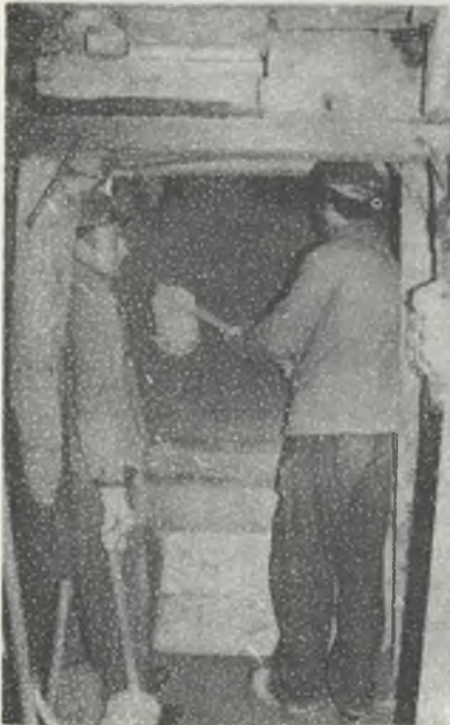
Fot. 5. Ręczne zagęszczenie pod- sadzki lessowo-cementowej
