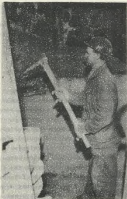
Fot. 2. Ręczne urabianie górotworu
