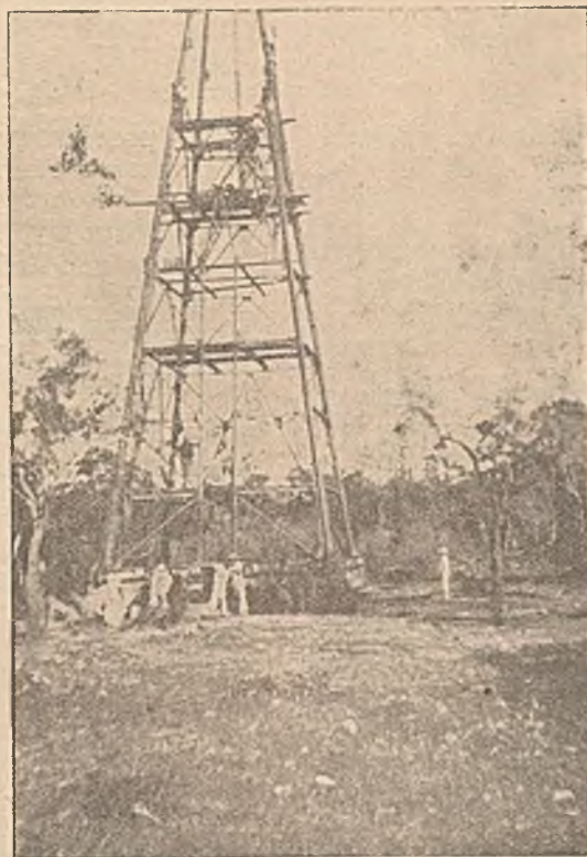
Montowanie wieży żelaznej.
