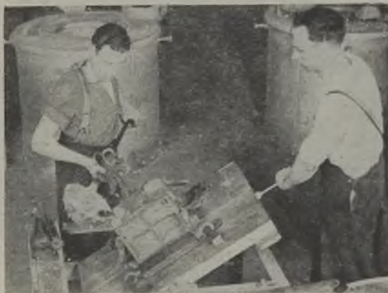
FIG. 32.—"SINGLE-HANDED" POUR OF "TILTING" DIE.
