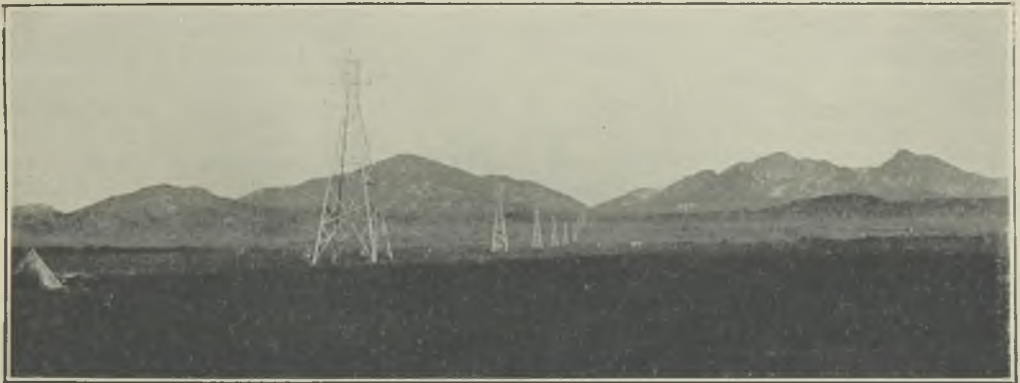
33 KV. TRANSMISSION LINE (BARAKIN LAHADI-DUROWA).
