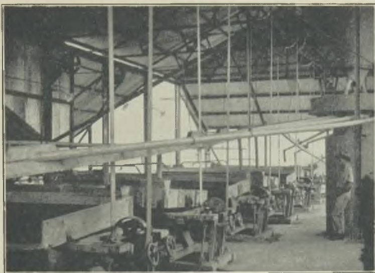
ABENAB MINE: OVERSTROM TABLES.
